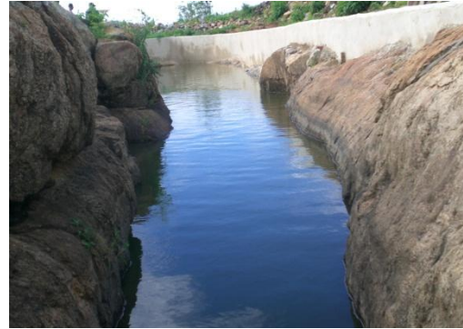
Ein fertiges Wasserprojekt
